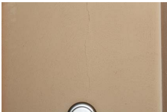
Bild 3: Erdgeschoss, Küche, Wandriss
