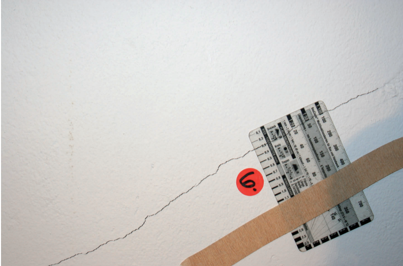
Abb. 9.1 Foto-Aufnahmedatum: 18.04.2007, Rissbreite = 0,3 mm
