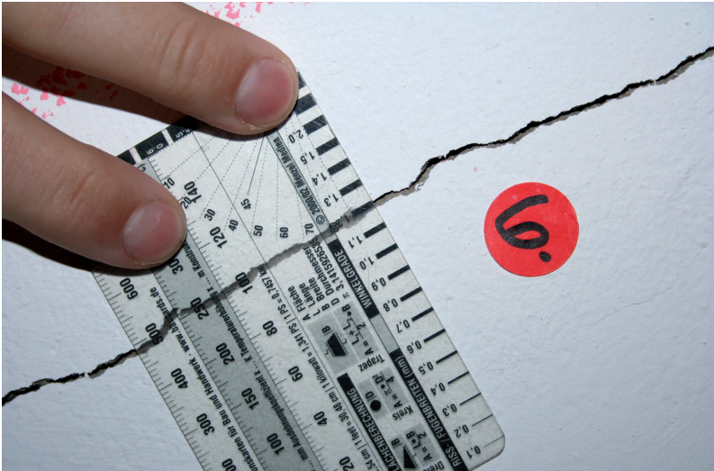
Abb. 9.2 Foto-Aufnahmedatum: 29.09.2008, Rissbreite = 1,2 mm
